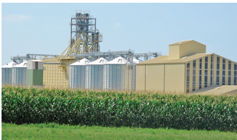
A Chabeuil , la CDC a mis en service un silo pour les céréales bio en 2013 (à gauche sur la photo), une usine d'aliments bio en 2014 (à droite) et un silo pour les productions conventionnelles en 2018.
